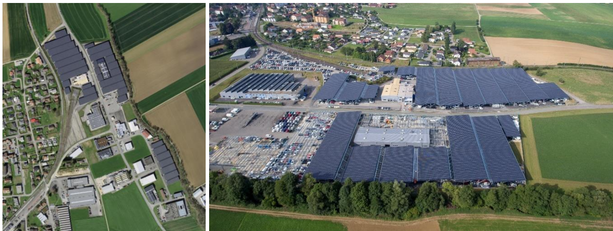
Figure 17: Centrale solaire de Courgenay
