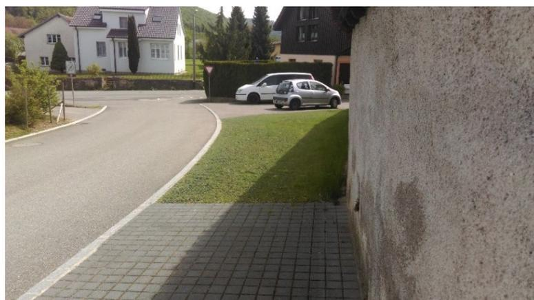
Pavés filtrants et grilles gazon (surfaces perméables)
